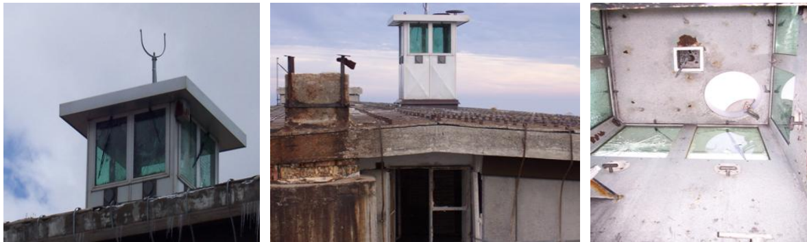
Garitta vista dal Piazzale, dal Tetto Blocco No-Break, e l'Interno visto dall'Ingresso alla Garitta stessa (2006)
