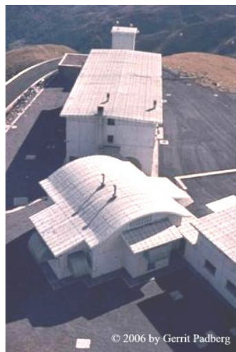
La Schermatura della Stazione Nella Foto manca la Garitta e la Seconda stanza Raffreddamento Blocco No-Break (1970)
