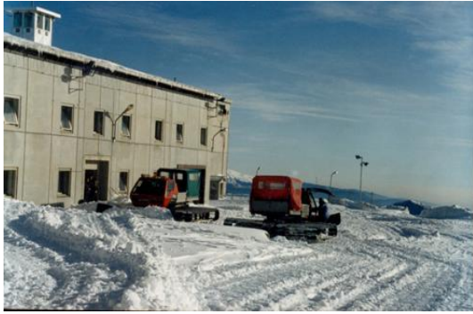
Blocco Alloggi con Garitta sul Tetto (1980)
