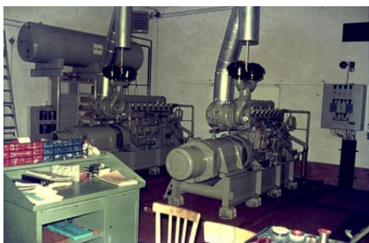
Generatori in Funzione (1971)
