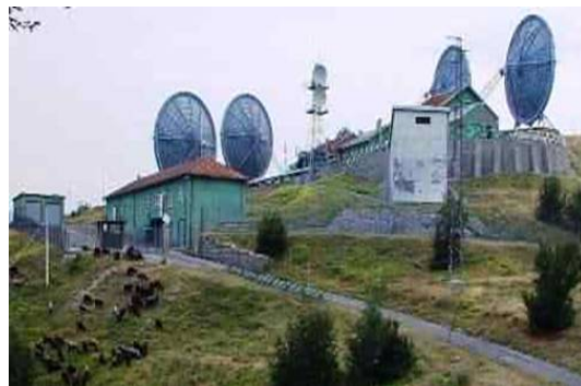
Stazione del Monte Giogo (IA) collegata in Microonde con il Dosso dei Galli (IDGZ) tramite la Stazione di Cavriana-Mantova (IMBZ)
