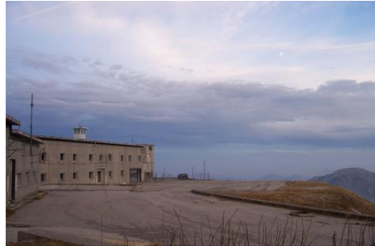
Blocco Alloggi vista dal Piazzale Superiore (2006)
